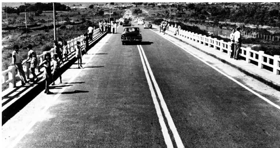
Inauguração do asfalto da rodovia Goianésia-Jaraguá
